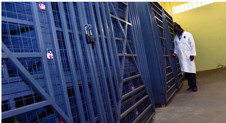
Fig. 2. Almacenamiento seguro en una instalación de Ghana en que se han incorporado diversos tipos de barreras físicas para impedir el robo de materiales radiactivos y el acceso no autorizado a ellos.
