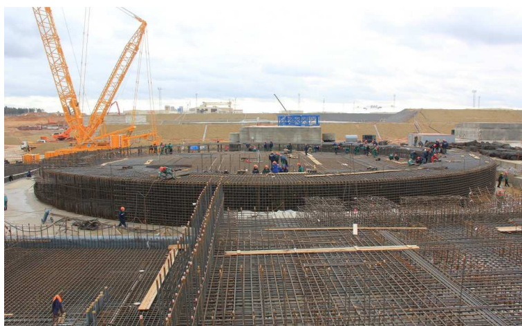
Fig. 1. Belarús inició la construcción de su primera central nuclear en el emplazamiento de Ostrovets el 6 de noviembre de 2013. (Fotografía por cortesía de la Dirección de Construcción de Centrales Nucleares de Belarús).
