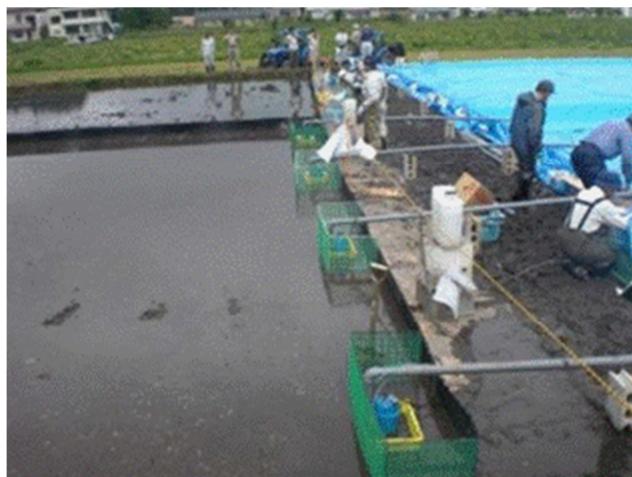
РИС. D.4. Осушение суспендированной почвы на затопляемых полях в Японии как один из вариантов восстановительных мероприятий (публикуется с разрешения МСЛРХ-НАРО).
