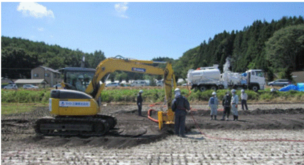
РИС. D.3. Экспериментальное удаление верхнего слоя почвы после применения отвердителя почвы (публикуется с разрешения Министерства сельского, лесного и рыбного хозяйства (МСЛРХ) / Японского агентства по атомной энергии (ЯААЭ) / Национальной организации по исследованиям в сельскохозяйственных и продовольственных отраслях (НАРО), Япония).
