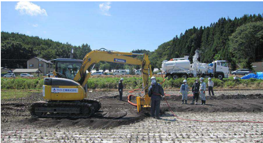
图 D.3. 施用土壤固化剂后的表土移除试验（照片由日本农林水产省/日本原子力开发机构)/日本国家农业和食品研究机构提供）。
