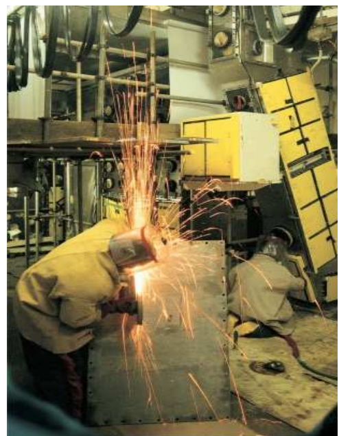
图1. 正在对一座燃料制造设施的手套箱实施退役。
