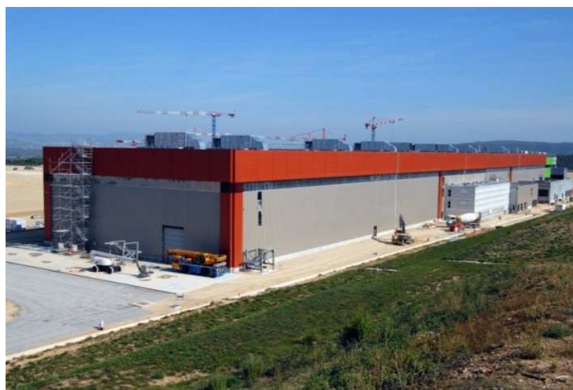
图 6. 国际热核实验堆首个竣工的建筑物 — 极向场线圈大厅。
