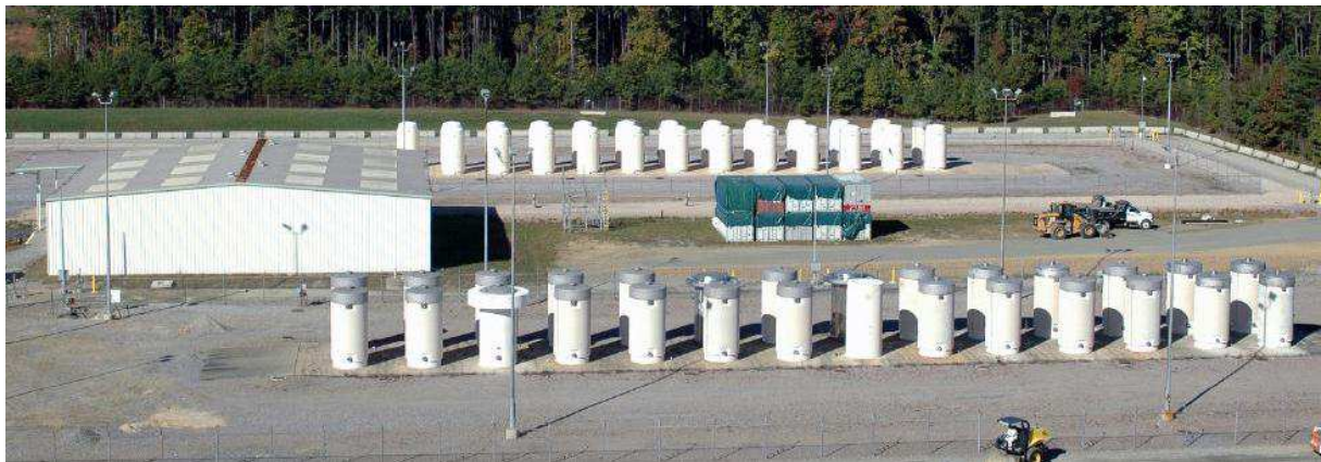
图 4. 美国弗吉尼亚州萨里核电厂的独立乏燃料贮存装置，它是一个反应堆现场干式容器贮存设施。
