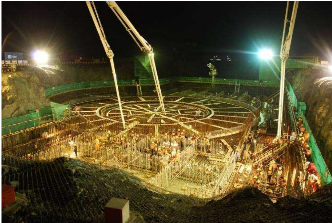
图 1. 中国三门核电项目场址浇注第一灌混凝土。
