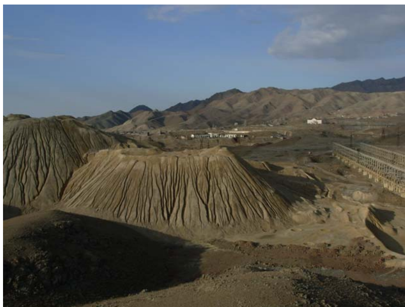
Fig. 4. Montón de residuos e instalación de lixiviación en un emplazamiento abandonado de Taboshar (Tayikistán) (en segundo plano, la aldea y la escuela).
