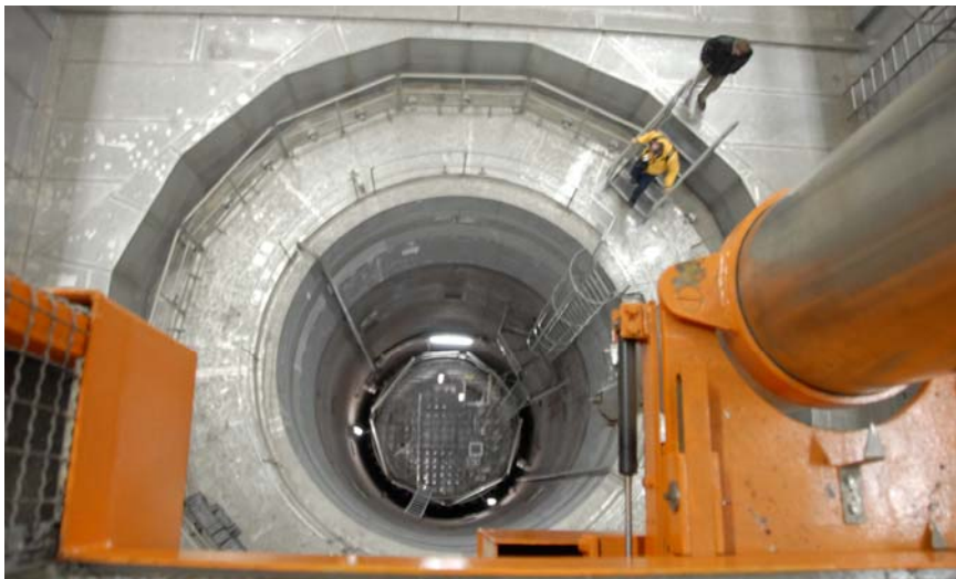
Fig. 6. Inspectores observan los elementos de diseño de un núcleo de reactor vacío.
