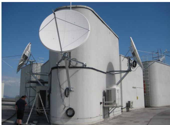
Fig. 7. Estación receptora de satélites de datos de monitorización a distancia en la Sede del Organismo.
