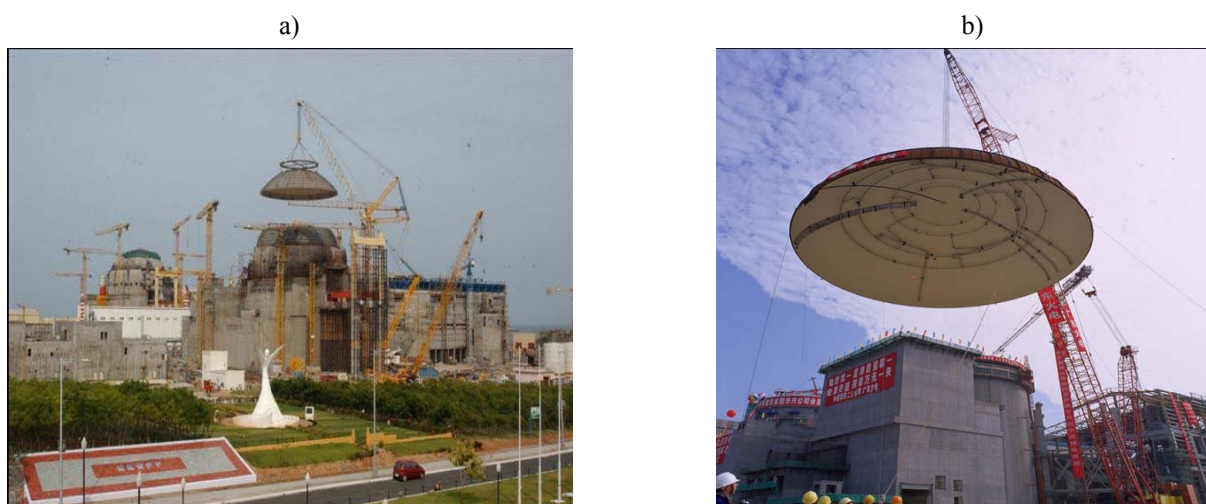
Fig. 2. Colocación con grúa de la bóveda de contención en: a) la central nuclear de Kudankulam (India) (fotografía cedida amablemente por la Nuclear Power Corporation of India Ltd) y b) la central Lingao-4 de China.
