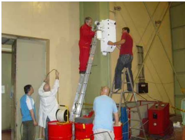
Fig. 2. Instalación de equipo de monitorización a distancia para mejorar la protección física de una instalación nuclear.
