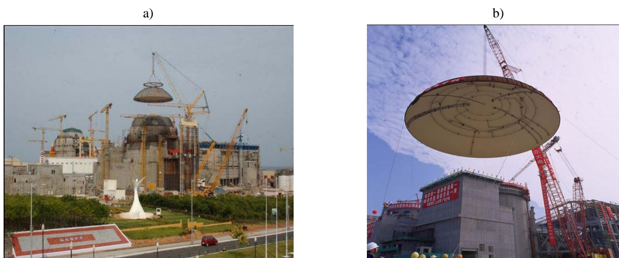
FIG. 2. Mise en place du dôme de confinement a) à la centrale nucléaire de Kudankulam en Inde (reproduction autorisée par Nuclear Power Corporation of India) ; et b) à la centrale de Lingao-4 en Chine.
