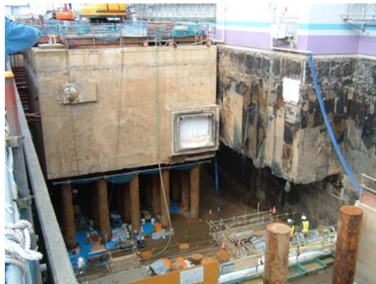
FIG. 2. Enlèvement, nettoyage et remplacement de sol contaminé par de l'huile autour des fondations d'une structure non liée à la sûreté à la centrale nucléaire de Kashiwazaki-Kariwa.
