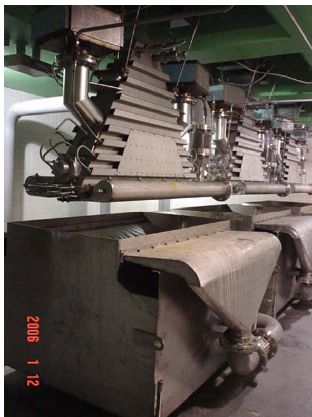
FIG.1. Primera planta de tratamiento de aguas residuales por haces de electrones a escala industrial en funcionamiento en la República de Corea.
