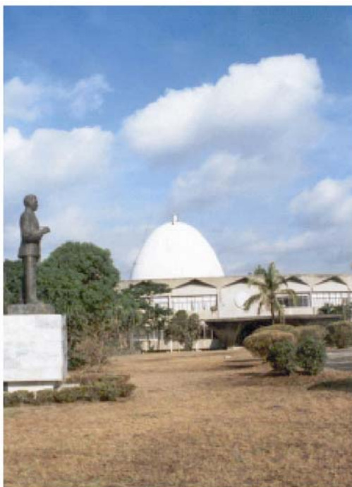
FIG. 1. El reactor de investigación PRR-1, de Filipinas, que servirá de modelo para el Proyecto de demostración sobre la clausura de reactores de investigación
