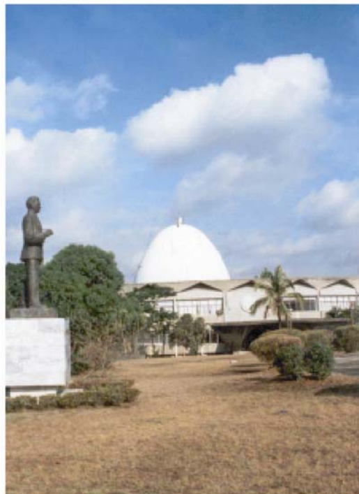
Fig. 1. Le réacteur de recherche des Philippines PRR-1 servira de spécimen pour le projet de démonstration du déclasséement d'un réacteur de recherche.
