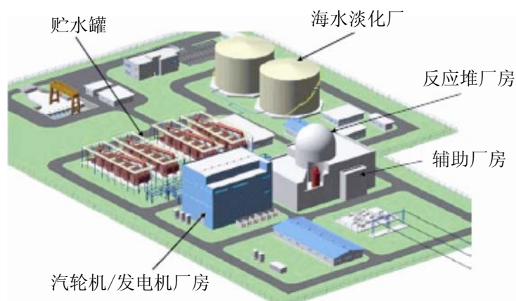
图 2. 一座中小型反应堆的例图——大韩民国的系统一体化模块式先进反应堆 (照片来源：韩国原子能研究院)。
