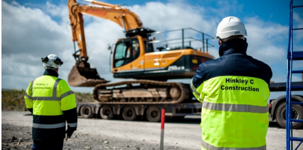
Des travailleurs sur le site de construction de la centrale Hinkley Point C.
