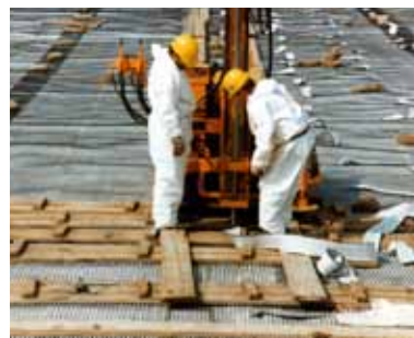
铀尾矿覆盖和排水综合方案的实施。
