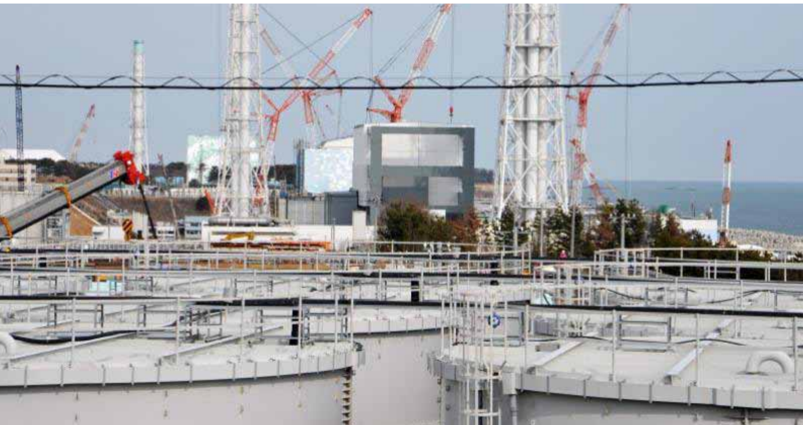
福岛第一核电站反应堆厂房前面的污染水贮罐。
