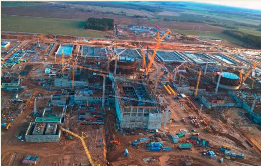
Строительство первой АЭС в Беларуси на площадке Островец.
