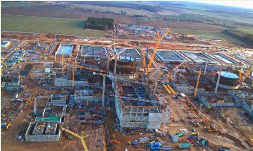
Le Bélarus construit actuellement sa première centrale nucléaire sur le site d'Ostrovets.
