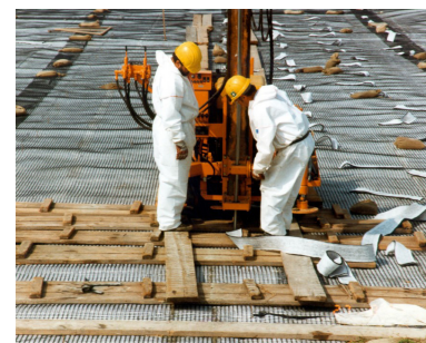
Application d'une double méthode pour recouvrir et évacuer des résidus de traitement d'uranium.
