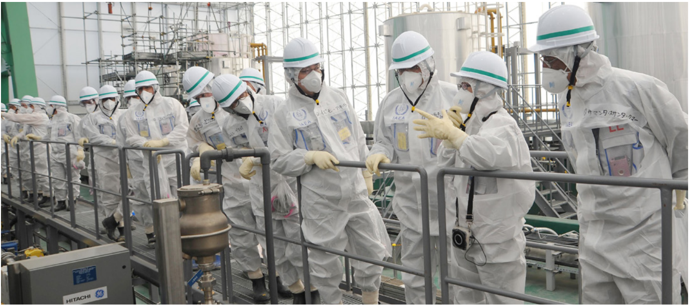
El equipo de clausura del OIEA escucha una explicación sobre el funcionamiento de un sistema de purificación que elimina casi todos los elementos radiactivos del agua contaminada.
