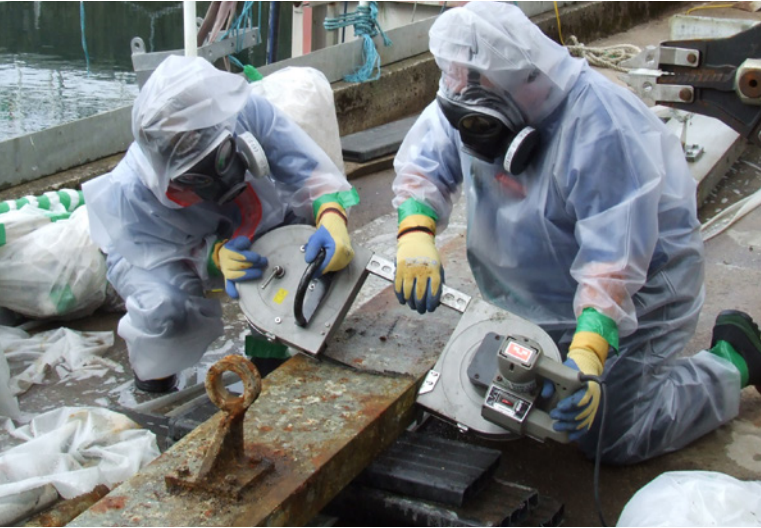
Personal encargado de la clausura cortando una pieza de un equipo grande de metal en una central nuclear.
