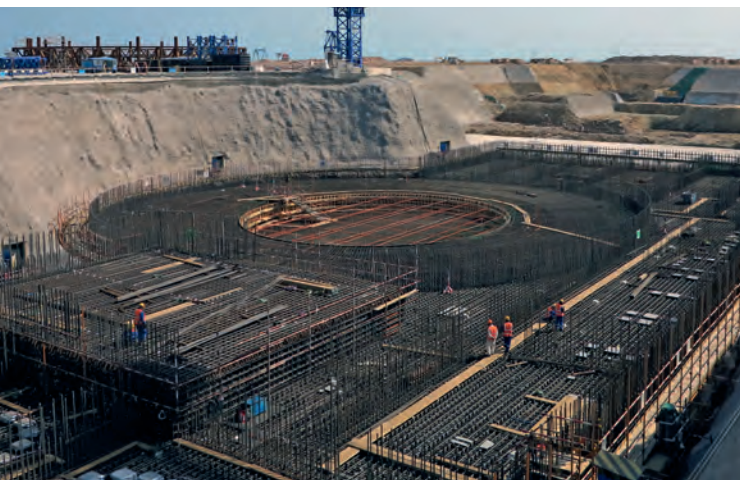
Central nuclear en construcción en China.
