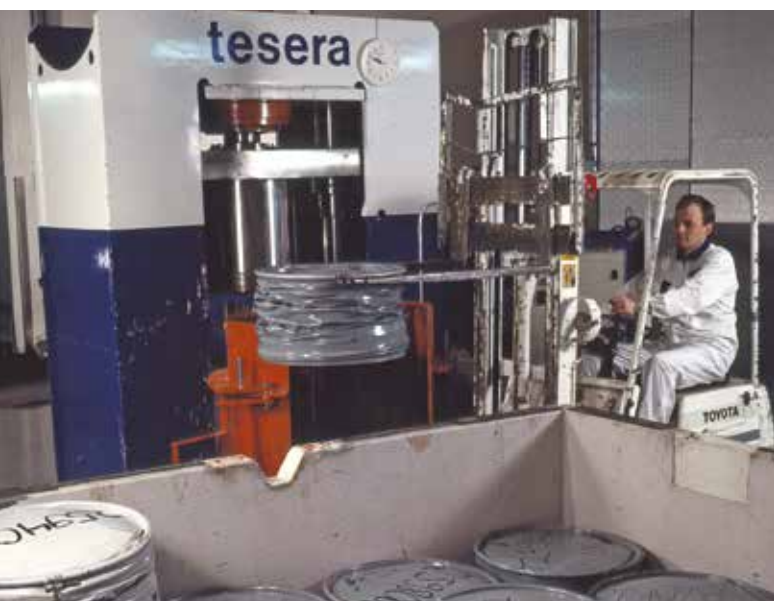
Supercompactor for solid waste drums (Photo: Teollisuuden Voima Oyj (TVO), Finland)
