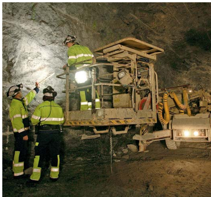
Подземные разведочные работы для нужд технико-экономического обоснования глубокого геологического захоронения высокоактивных отходов. (Фото: компания "Посива", Финляндия)
