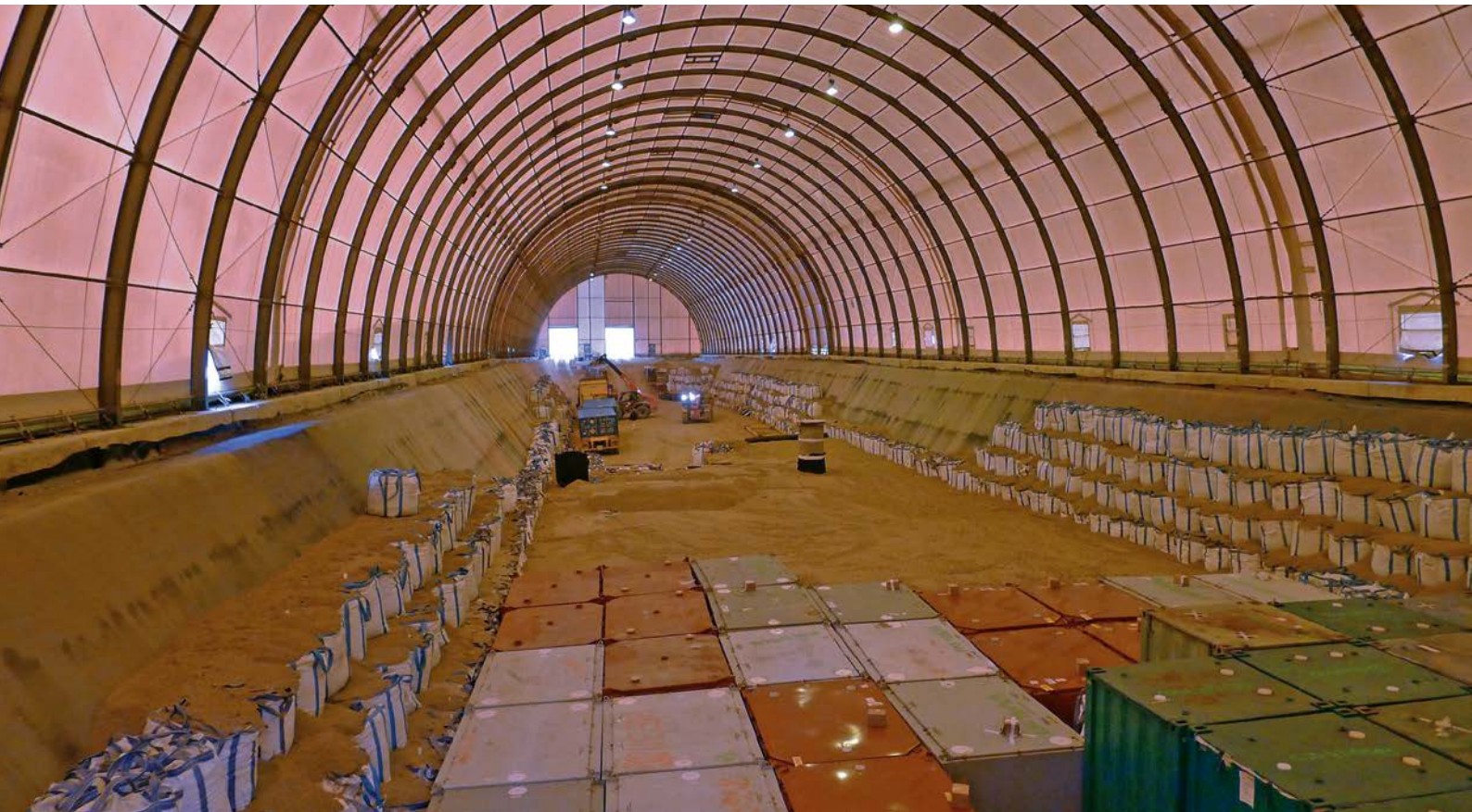
Tranchée de stockage définitif de déchets de très faible activité à l'installation de stockage définitif du CIRES, en France.
