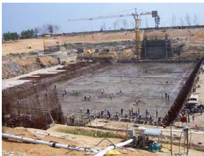
РИС. 2. Строительство быстрого реактора в Калтаккаме, в Индии.
