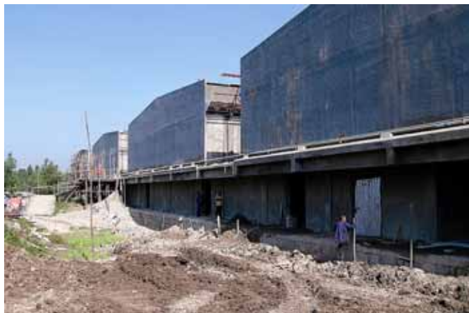
Рис. 2. Строительство станции массового разведения мухи цеце в Эфиопии.
