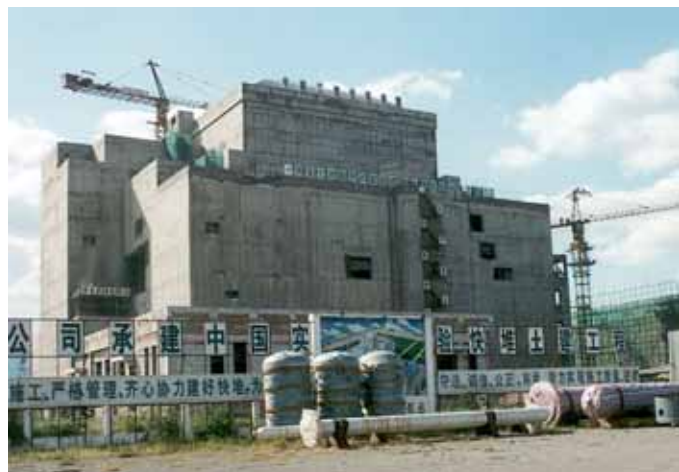
РИС. 2. Строящийся Китайский экспериментальный быстрый реактор.
