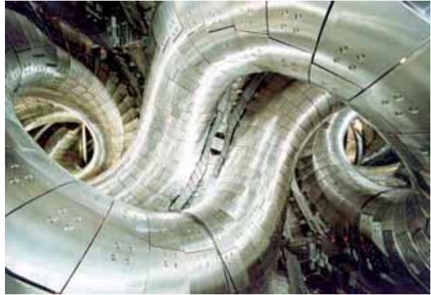
图 2. 日本仿星器 LHD 真空室（采用了环状核聚变约束概念）内视图示出包覆的线圈系统螺旋绕组。聚变等离子体被真空室内的线圈所约束。
