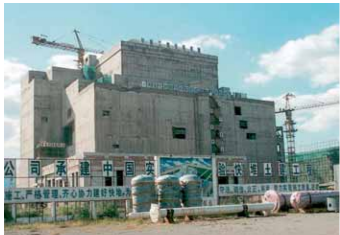
图 2. 建设中的中国实验快堆。
