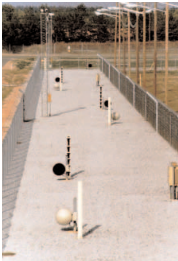
图1. 用于探知和评估闯入核设施者的实物保护系统外景实例。
