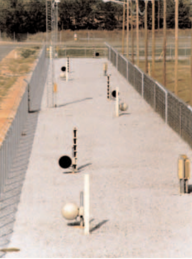
الشكل (1) مثال لنظام للحماية المادية الخارجية بغرض كشف وتقييم عمليات اقتحام مرفق نووي.
