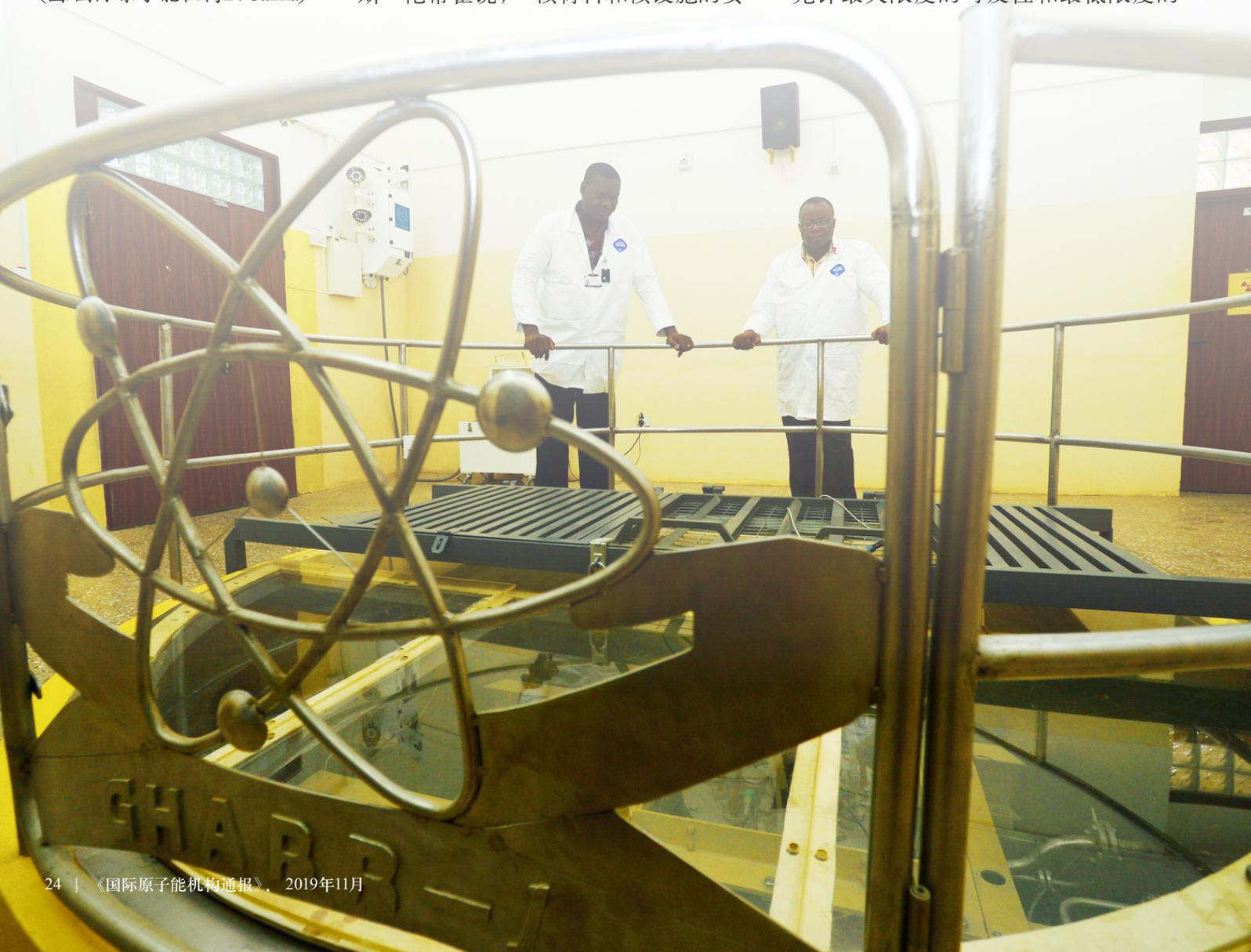
实物保护措施布置的。例如，使用开放式池型设计建造的研究堆可以很容易地接触到反应堆堆芯中发现的核材料。对于教育目的而言，这是一种高效的设计，但可能会带来安保风险。
