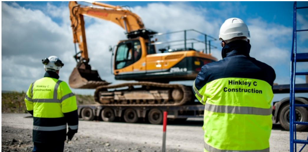
欣克利角C建筑工地的工人 (图/法电能源公司)
