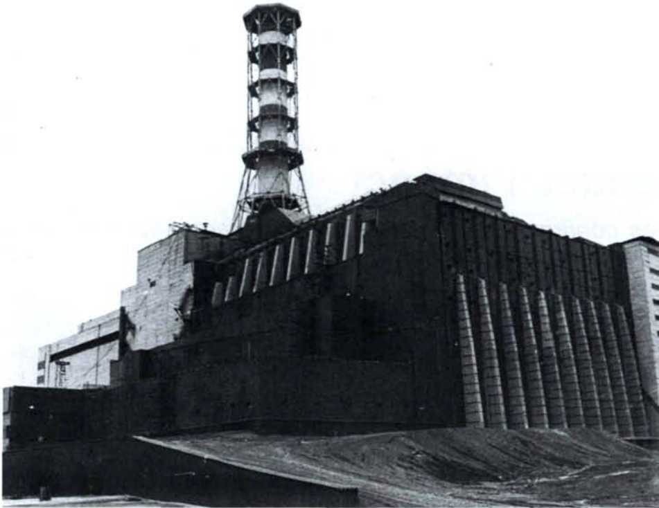
Le réacteur endommagé de Tchernobyl a été encapsulé dans une structure appelée «enveloppe» (généralement connue sous le nom de «sarcophage») mise en place pour retenir les matières radioactives et empêcher la contamination de l'environnement.
