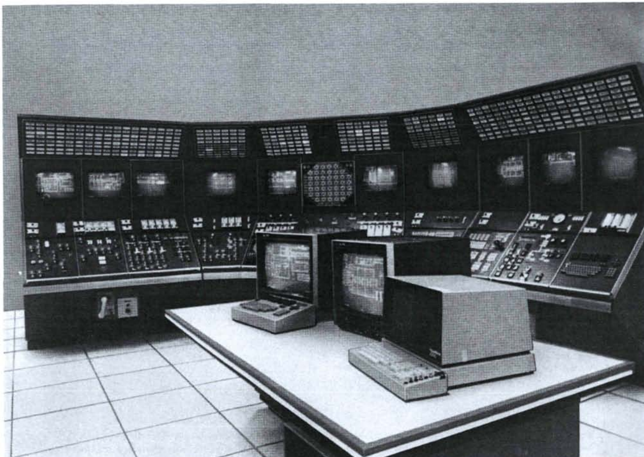
Les simulateurs de centrale reproduisent une salle de commande déterminée: en haut, le simulateur de la centrale nucléaire du Susquehanna, aux Etats-Unis; en bas, celui de la centrale nucléaire CANDU «B» de l'Ontario Hydro Bruce, au Canada. (Photos: Link SSD et CAE Electronics Limited)
