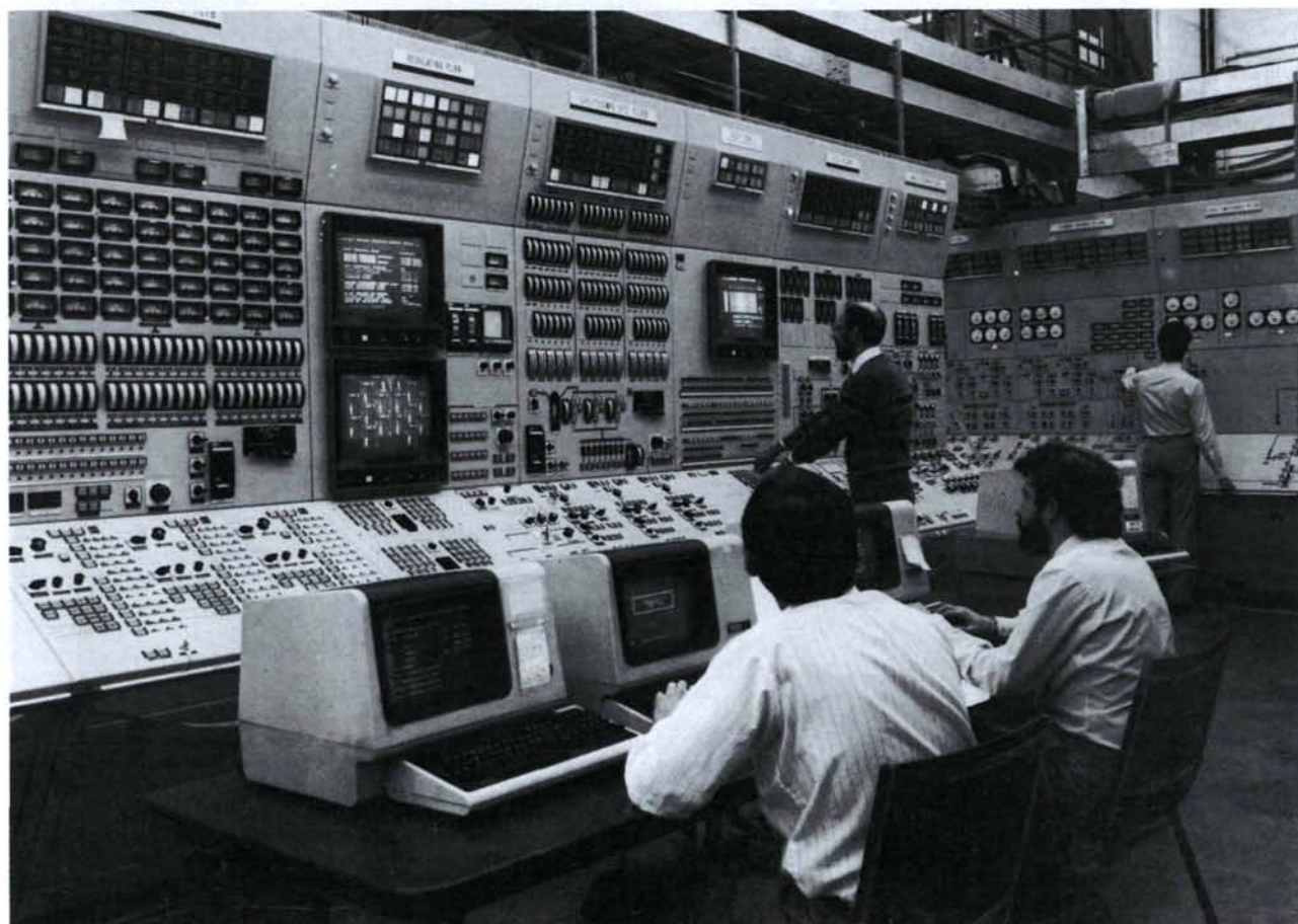
Les simulateurs de centrale reproduisent une salle de commande déterminée: en haut, le simulateur de la centrale nucléaire du Susquehanna, aux Etats-Unis; en bas, celui de la centrale nucléaire CANDU «B» de l'Ontario Hydro Bruce, au Canada. (Photos: Link SSD et CAE Electronics Limited)
