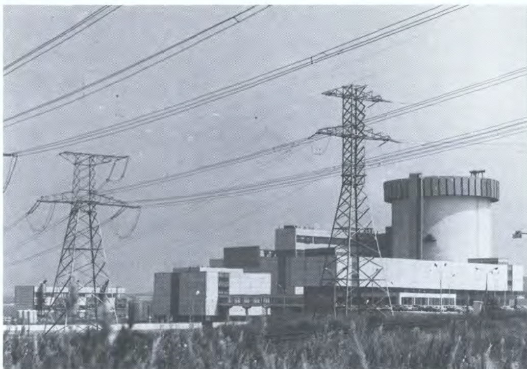
Часть Нововоронежской АЭС с реакторами ВВЭР
