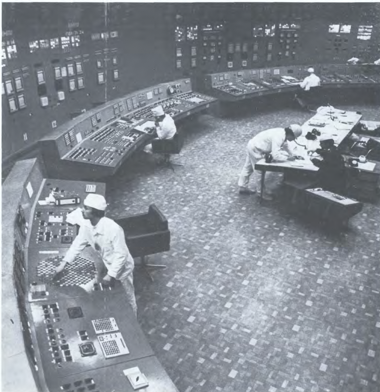
Пульт управления реактором РБМК мощностью 1000 МВт на Смоленской АЭС, одного из самых современных энергетических реакторов в Советском Союзе
