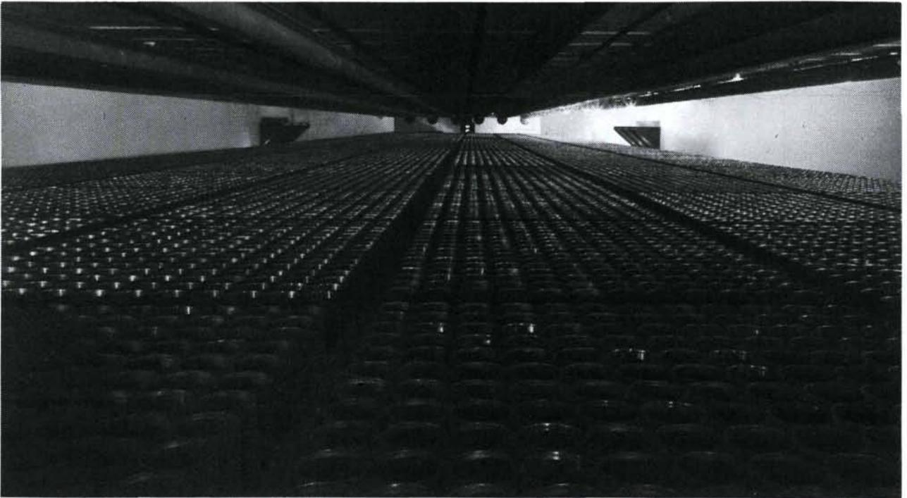
Figure 3a. Casemate de stockage à sec pour le combustible épuisé du réacteur refroidi par un gaz de Wylfa (Royaume-Uni).
