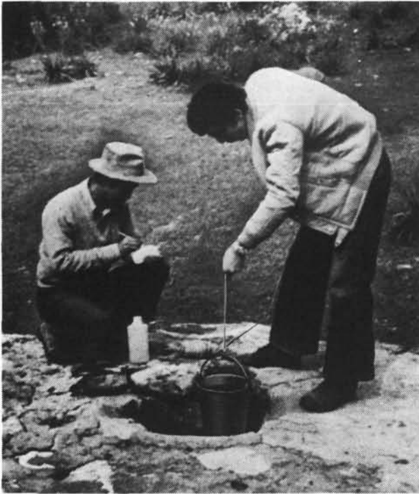
Figura 6. Tomando muestras de agua de un pozo de utilización doméstica (Turquía) a fin de analizar su contenido de radón y uranio.
