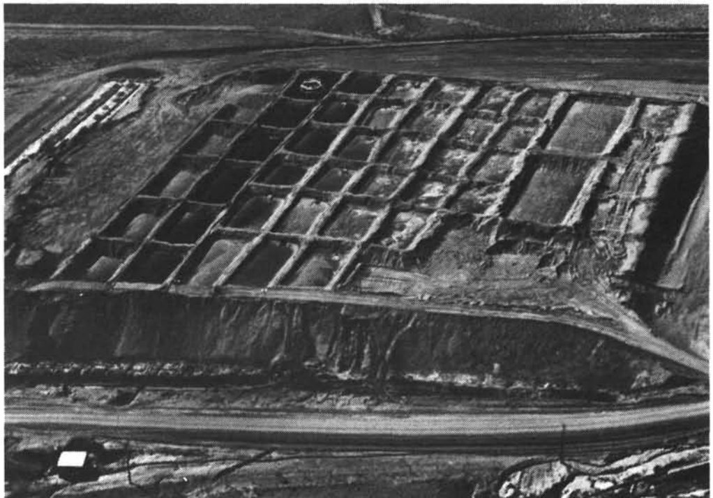
Instalación de lixiviación en pilas, en Wyoming (EE.UU.); el uranio se extrae de materiales de baja ley a medida que la solución de lixiviación fluye a través de las pilas de mineral. Mediante los métodos descritos en este artículo se protege el entorno contra los efluentes y desechos resultantes de este y otros tipos de operaciones de tratamiento de mineral.
