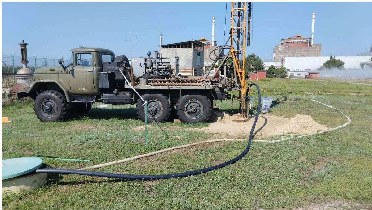
Perforación de más pozos en el emplazamiento de la ZNPP (Fotografía: Rosatom)
