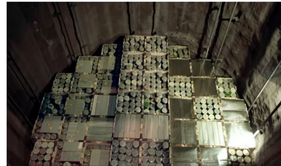
Matala-aktiivisen jätteen loppusijoituslaitos Olkiluodossa. Keski- ja matala-aktiiviset ydinjätteet loppusijoitetaan kalliopeirään noin 60 metrin syvyyteen. KUVA: RAINE LEHTORANTA
