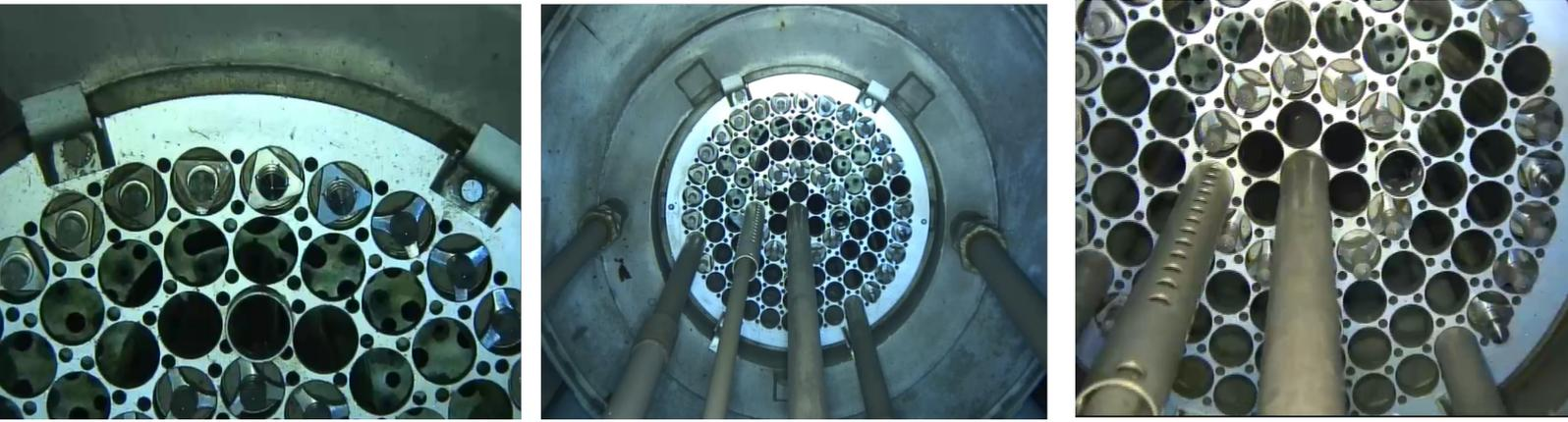
L'examen visuel et les essais non destructifs permettent d'évaluer la sûreté et les conditions de fonctionnement des structures, systèmes et composants d'une installation de réacteur, y compris la plaque de support et la grille du cœur du réacteur.
