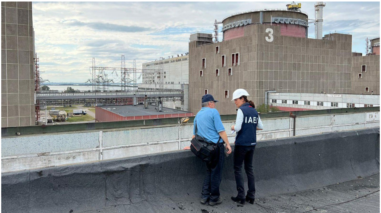
La Directora General Adjunta, Jefa del Departamento de Seguridad Nuclear Tecnológica y Física, Lydie Evrard, visita junto con personal del OIEA la terraza del edificio especial de la ZNPP que alberga, entre otras cosas, el combustible nuclear no irradiado y la instalación de almacenamiento de desechos radiactivos sólidos. (Fotografía: OIEA)
