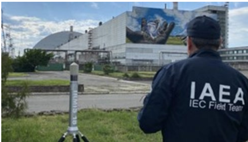
Detector IRMIS del OIEA instalado cerca del edificio administrativo de la ChNPP durante la misión a Ucrania realizada entre mayo y junio. (Fotografía: OIEA)
