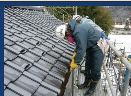
住宅の雨どいの堆積物除去
