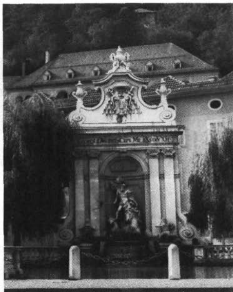
La Pferdeschwemme (abreuvoir) a été construite pour les chevaux des écuries de l'archevêque.
