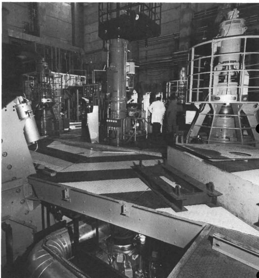
Vista interior del edificio del reactor Phénix en el piso 8,50. La fotografía muestra la parte superior del cierre giratorio y de los mecanismos de manipulación del combustible. A la derecha está el motor auxiliar y de bombeo. Bajo el piso se ve la tubería del circuito secundario del sodio ... P. Jahan
