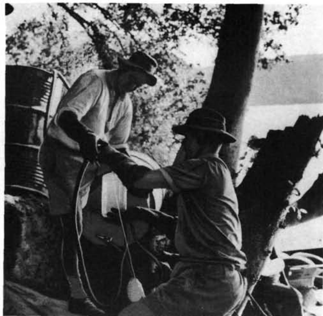
Llenado de los frascos de plástico con agua marcada con tritio: Sres. Proctor y T.T. Bestow, ambos de la Sección de Hidráulica del Ministerio de Obras Públicas de Nairobi.
