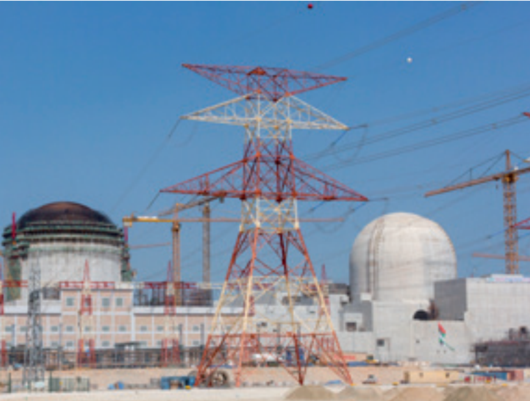
أعمال البناء في محطة بركة للطاقة النووية، الإمارات العربية المتحدة، (الصورة من: مؤسسة الإمارات للطاقة النووية)
