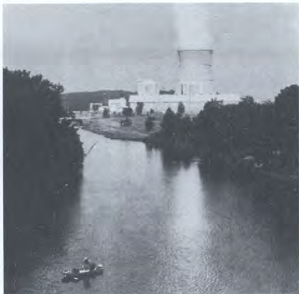
美国阿肯色-1核动力厂的2号机组。离阿肯色河约半英里的引水渠是著名的钓鱼区。该核动力厂向大约20万个用户供电，是美国100多座运行中核动力厂之一。（来源：美国原子工业工会）
